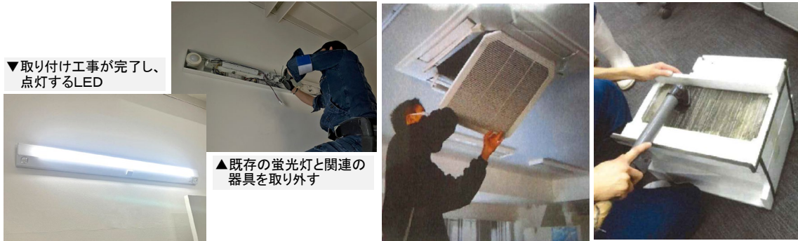
▲当センターで実施されたLED化工事 (写真提供：株式会社大塚商会＝2023(令和5)年2月)
