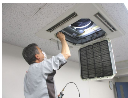
▲当センターで実施された冷媒漏洩検査（2025(令和7)年4月） 屋上に設置された室外機（左上）、フロンガス漏えいの有無（右上）、油の漏えいの有無（右下）、運転データ（左下）の各検査
